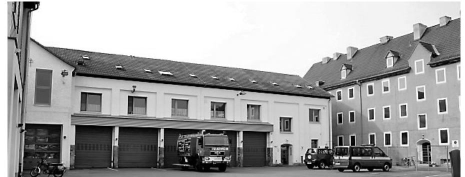
Hof der Alten Feuerwache
