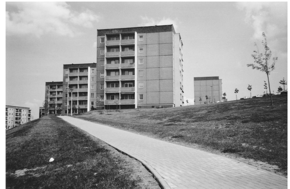
Platte in Gera-Bieblach-Ost 1993. Vielleicht bald ein neues Hausprojekt?
